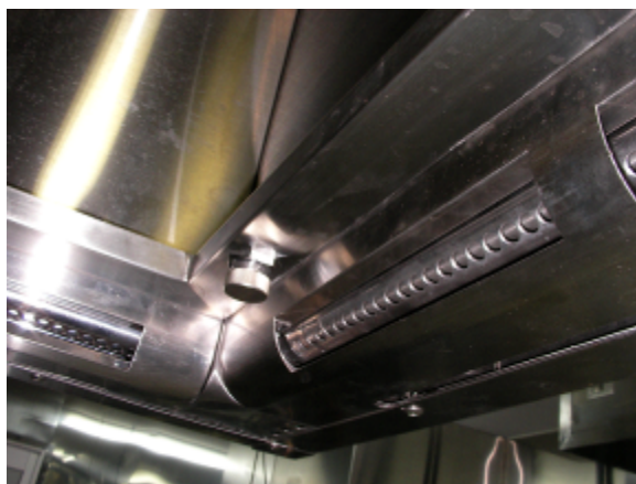
「写真一1 DRV 回転 NEF・停止時」
